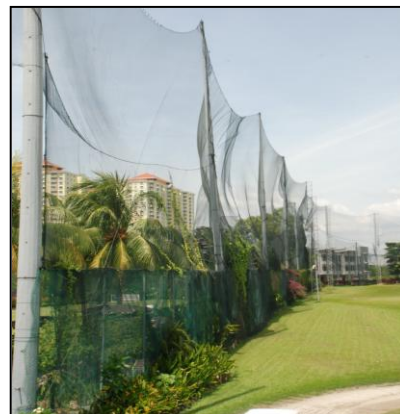
Foto 6: Jaring keselamatan yang disediakan di Setapak Driving Range , Kuala Lumpur
